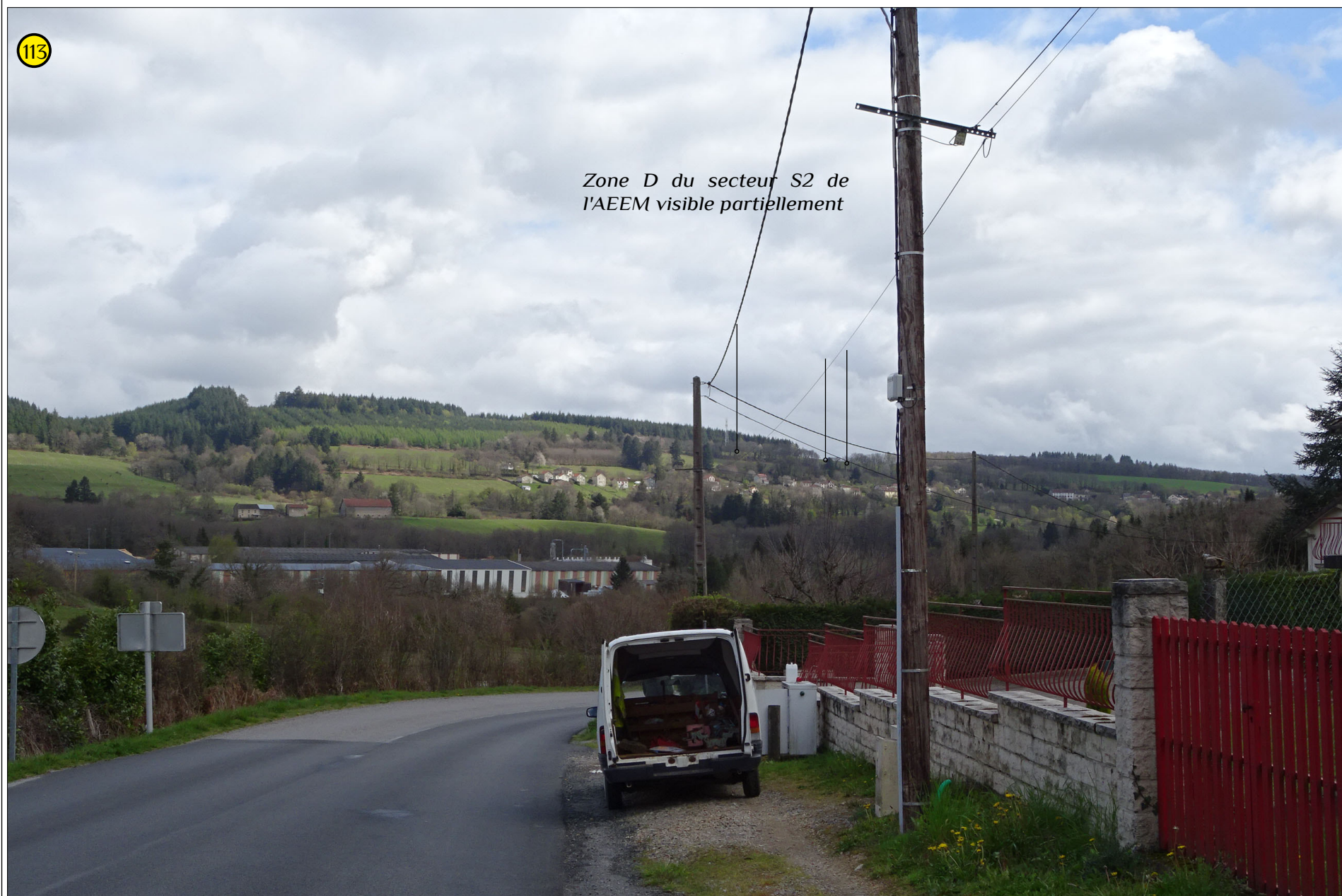
Depuis la D912 au niveau de la frange sud de Masbarraud-Mérignat, les ouvertures visuelles existent ponctuellement vers la zone D du secteur S2 de l'AEEM mais la vision est très partielle
